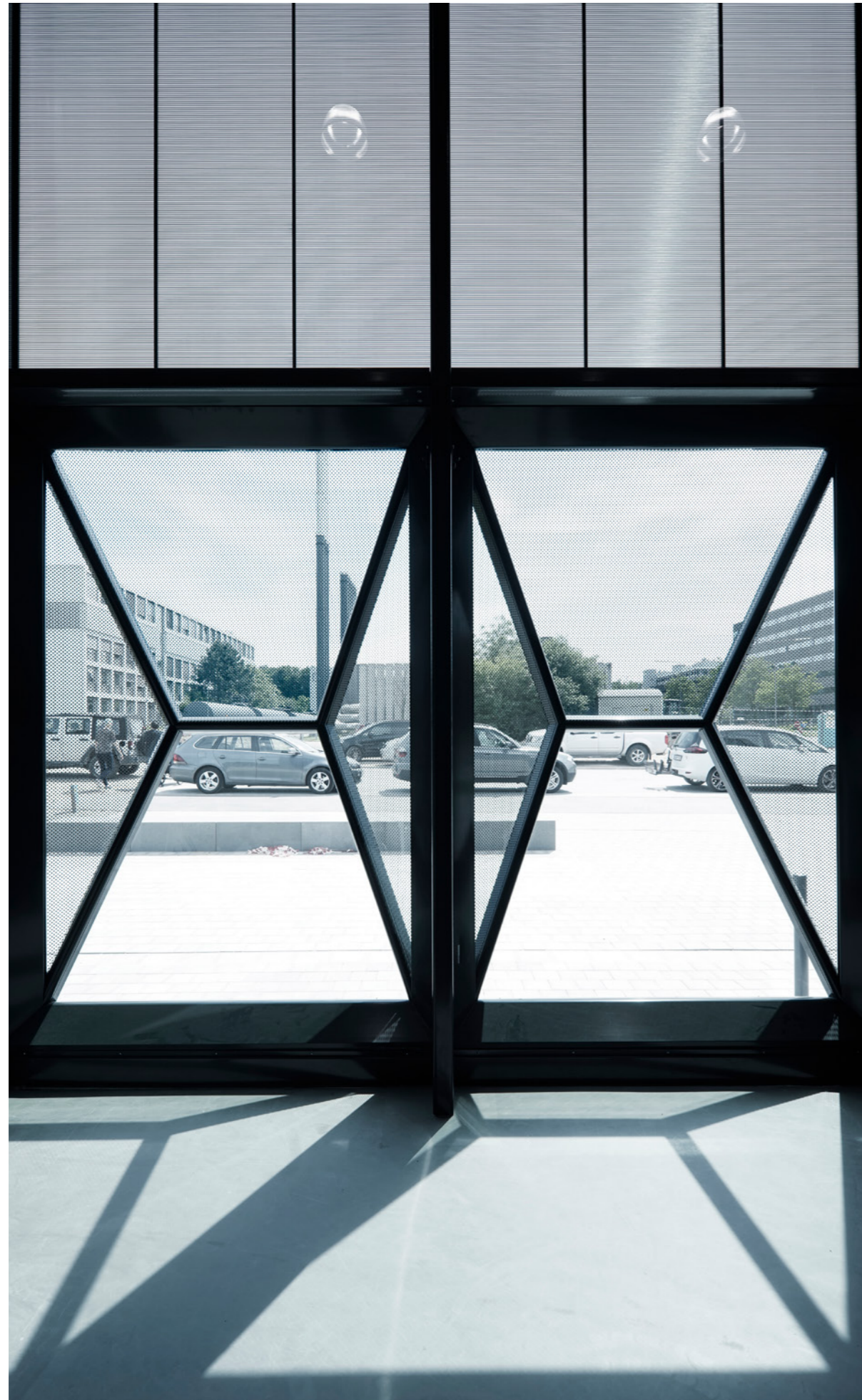
Blick durch die Südfassade der ETA-Fabrik
